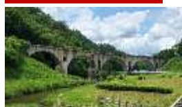
めがね橋と 道の駅みやもり
